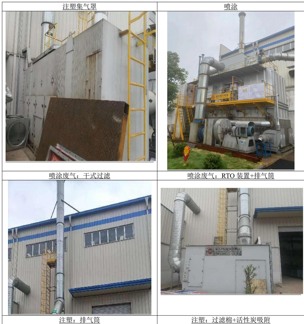
**图 4.1-2 项目废气处理设施照片**
