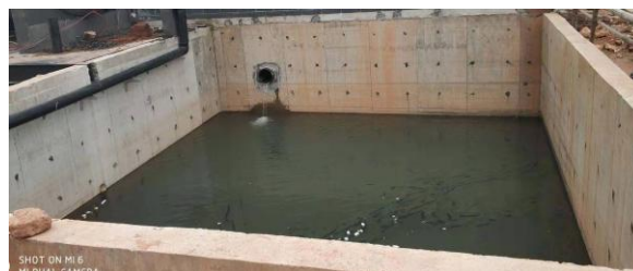
2 个循环水池（已做防腐防渗处理）及 1 个消防水池
