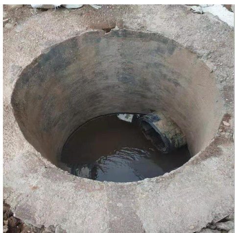
污水收集池（已做防腐防渗处理）
