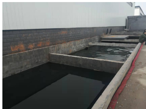
2 个循环水池（已做防腐防渗处理）及 1 个消防水池
