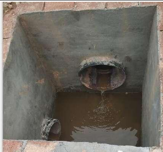
污水收集池（已做防腐防渗处理）
