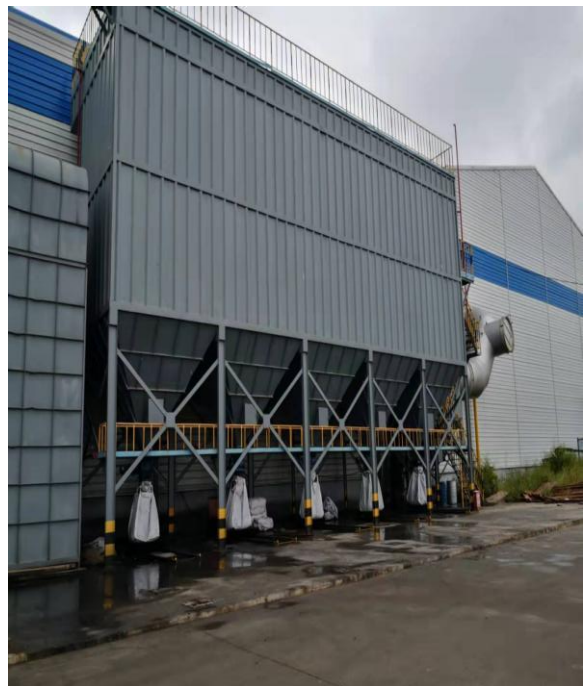
熔炼：脉冲布袋除尘
