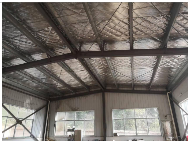
新建辅助间外部
