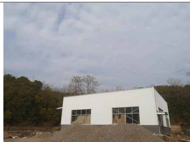
新建辅助间外部
