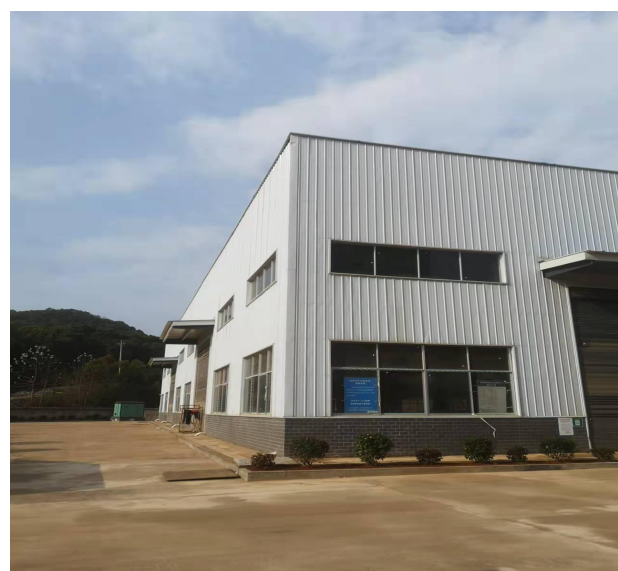
新建已检气瓶暂存棚外部
