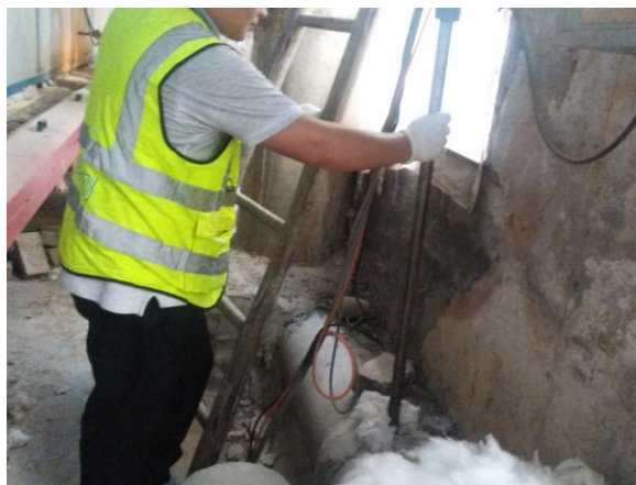
烧成废气排气筒出口
