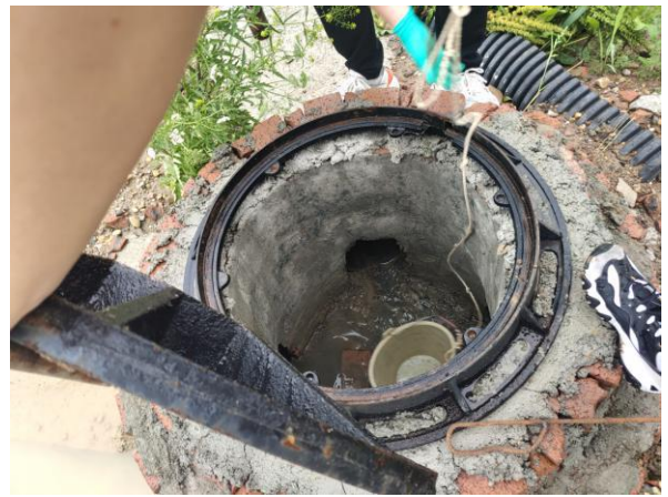
雨水沉淀池出口
