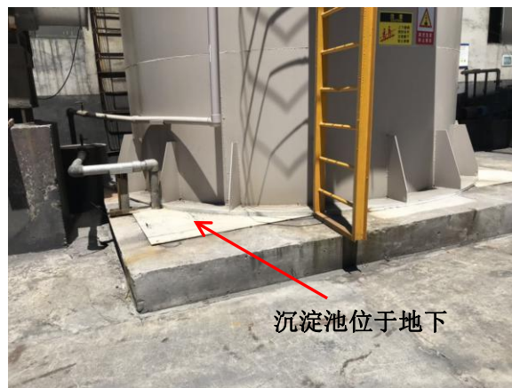
废气处理设施废水
