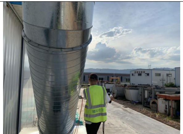
喷涂废气进口采样照片
