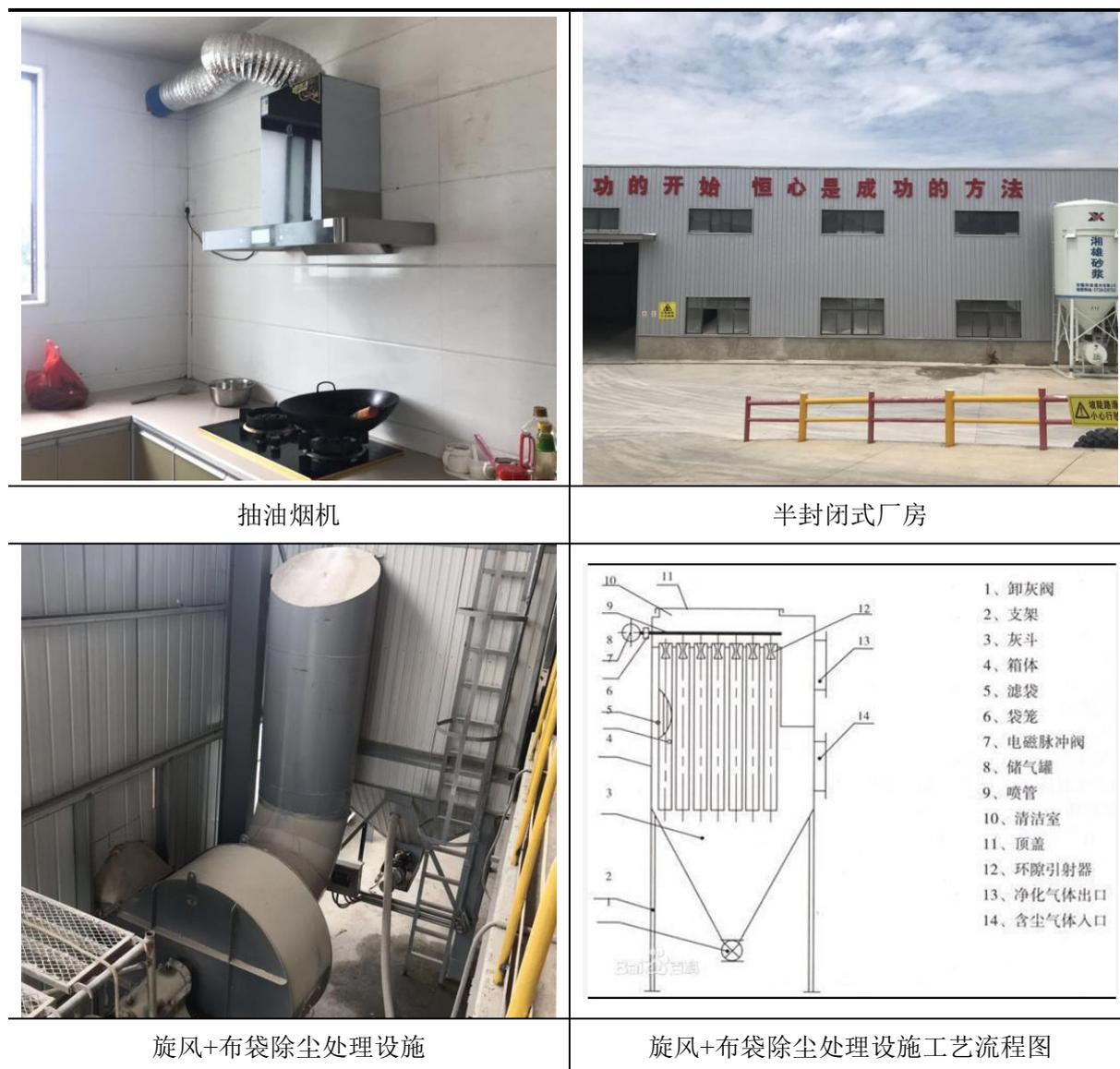
图 4-2 废气处理设施照片
