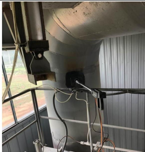
有组织废气进口采样照片
