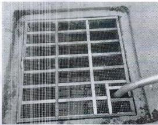
图三：储罐区水封井
