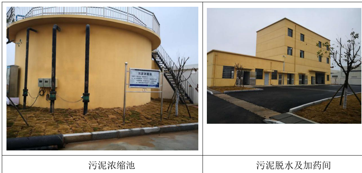
图 4.1-2 项目固废处理设施照片
