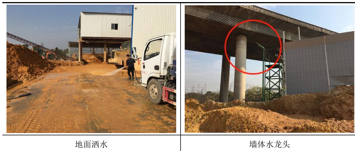
图 4-2 废气处理设施照片
