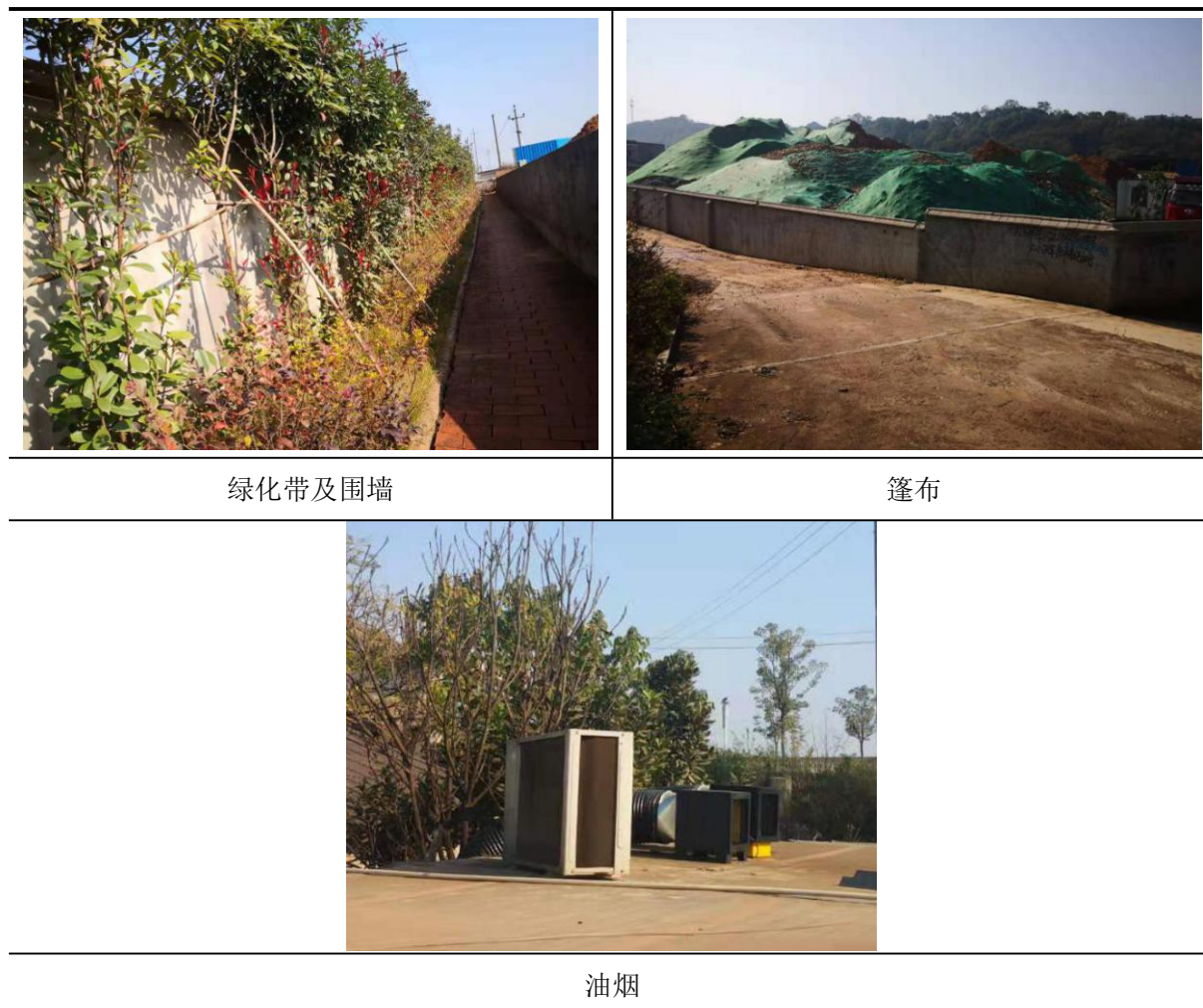
图 4-2 废气处理设施照片
